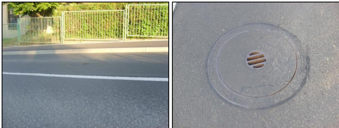
Abb. 25 Lärmarme Schachteindeckung (Beispiel Dresden)
