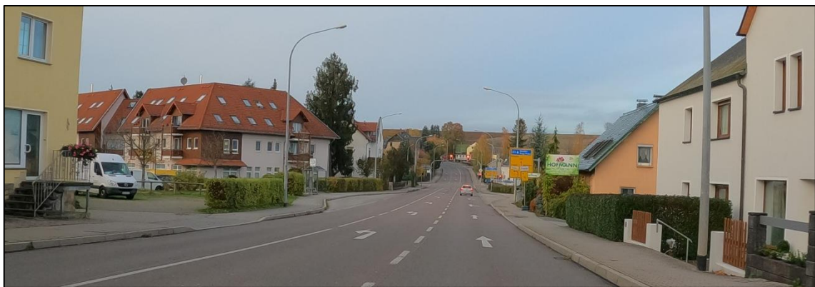
Abb. 18 Bestandssituation Hauptstraße Straße OT Possendorf
