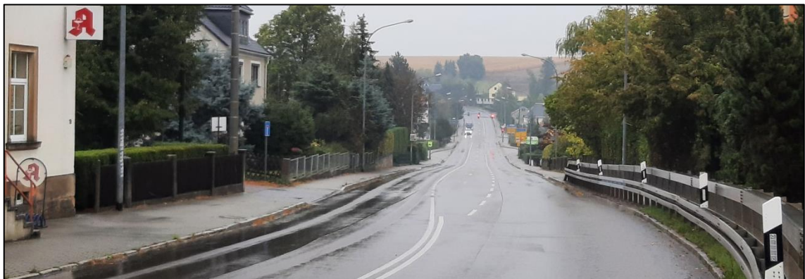
Abb. 22 Bestandssituation Hauptstraße Straße OT Possendorf
