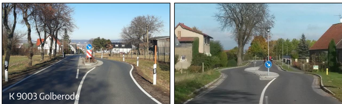
Abb. 26 Beispiele Ortseingangsgestaltung mit Fahrstreifenversatz
