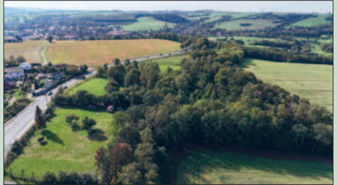
Von Bergbaulandschaft kaum noch etwas zu sehen: Der Standort von Schacht und Halde des Berglust-Schachtes auf Wilmsdorfer Flur an der B170 zwischen Hänichen und Possendorf.
